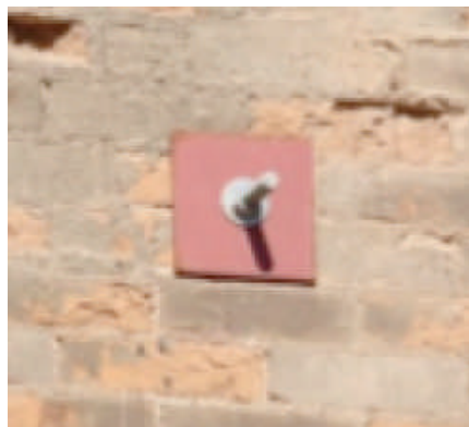
Una placa de acero con pernos de anclaje.
